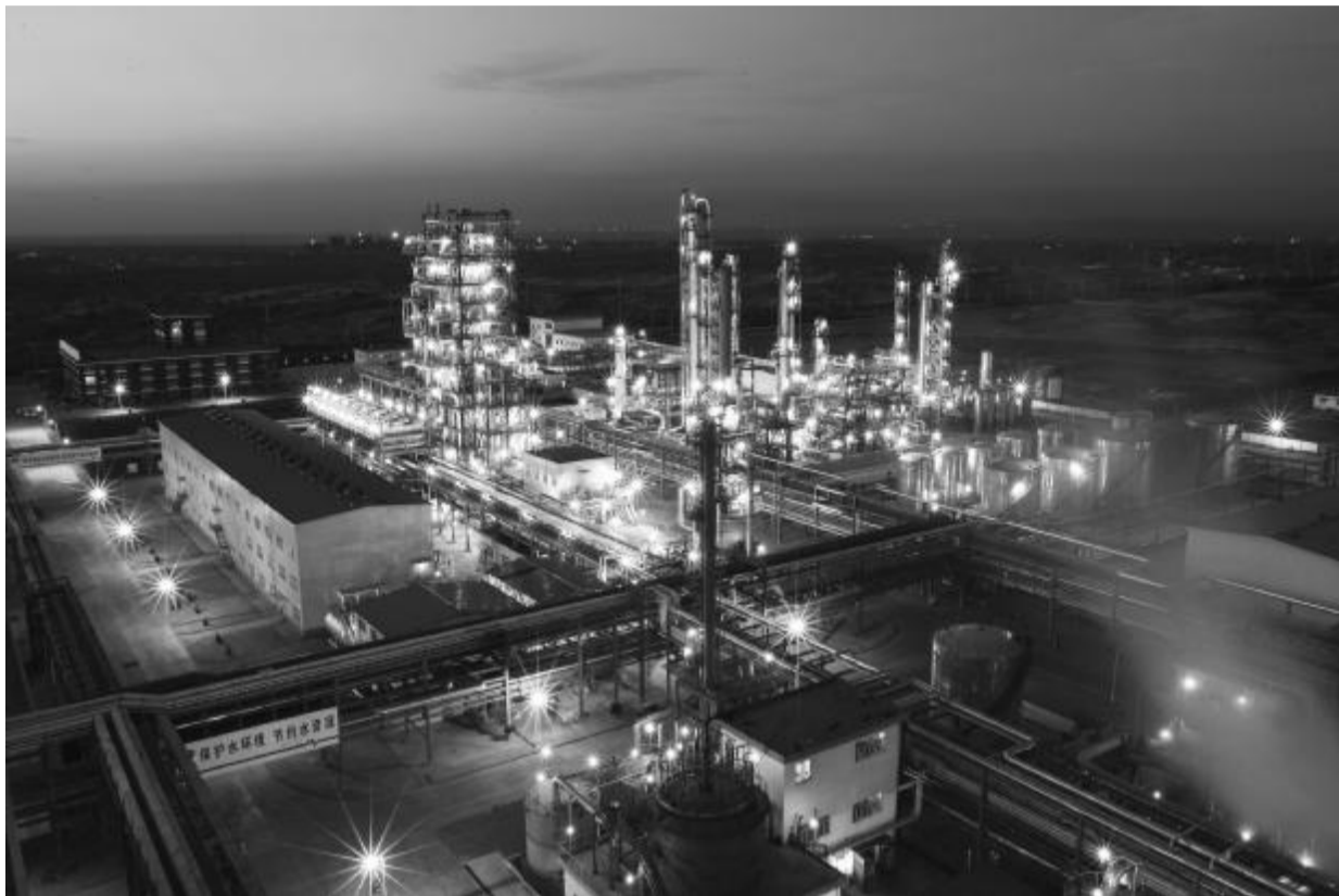
伊泰煤制油项目
