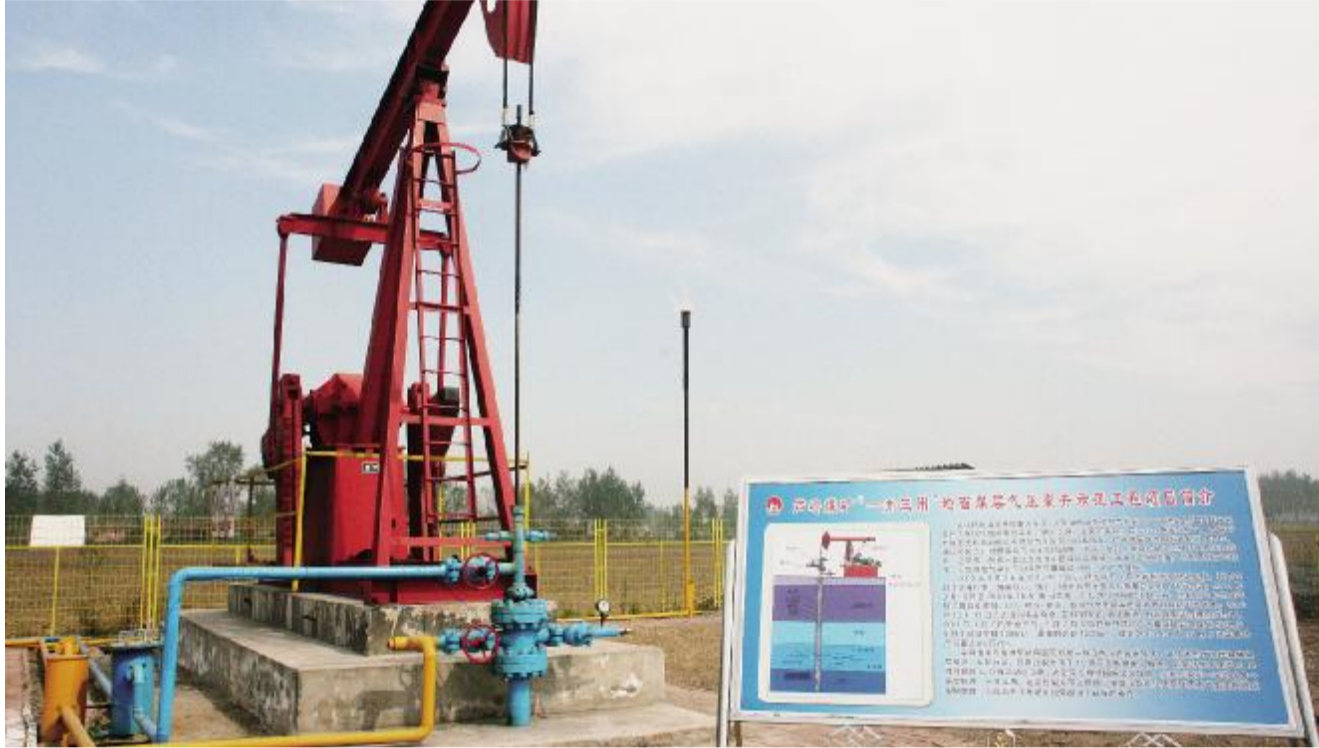
“一井三用”地面煤层气增压井示范项目
