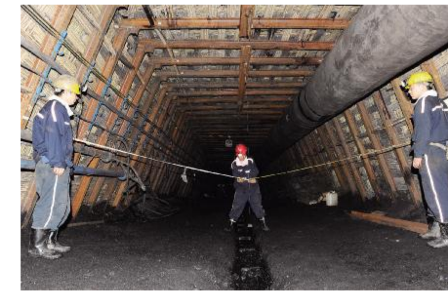
矿职工在测量巷道，确保巷道标准化 张子君/摄
