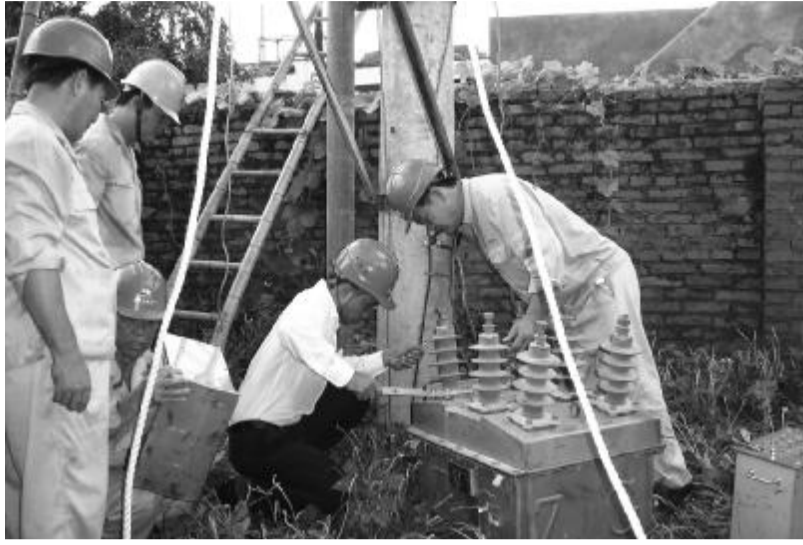
杨寅(右二)在博鳌保电中指导员工安装环网柜
