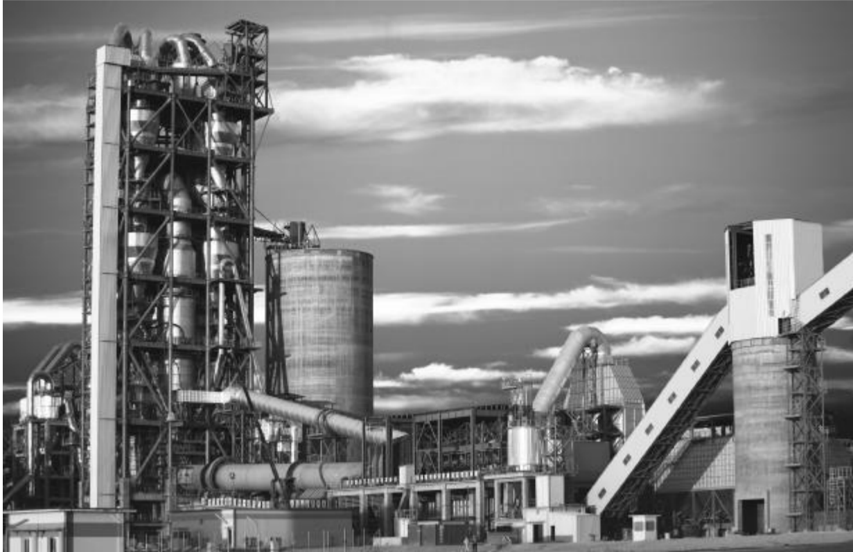
中材集团承建的叙利亚ABC项目
