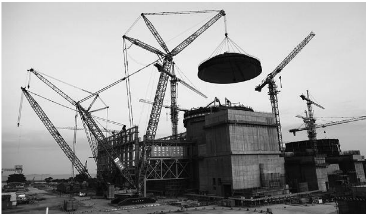
广西防城港核电站一期1号机组穹顶近期吊装成功,这标志着该机组建设全面由土建阶段进入安装调试阶段。防城港核电站由中国广东核电集团有限公司与广西投资集团有限公司共同出资建设,是中国西部少数民族地区首座核电站,预计首台机组将于2015年初投入商业运行。 CNS 供图
