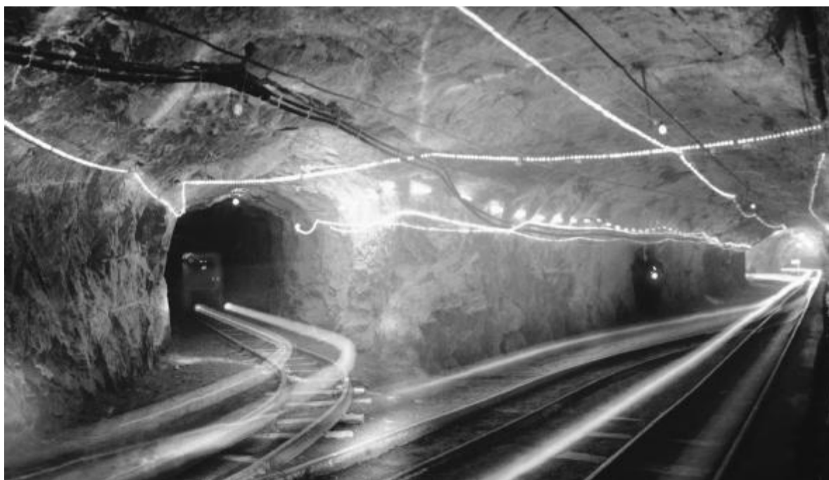
中矿集团井下运输巷道
