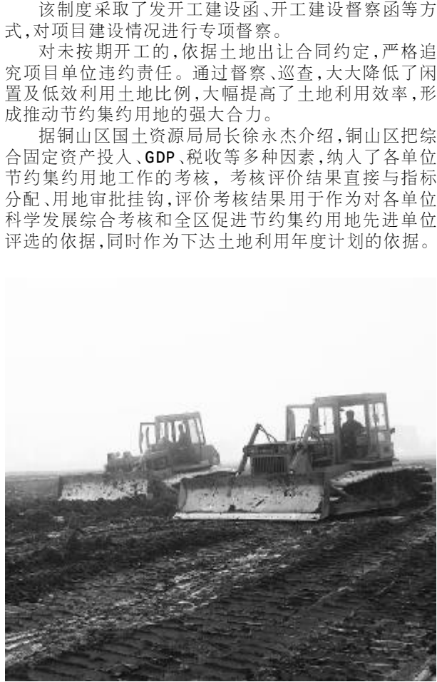
铜山区基本农田复垦整理现场
