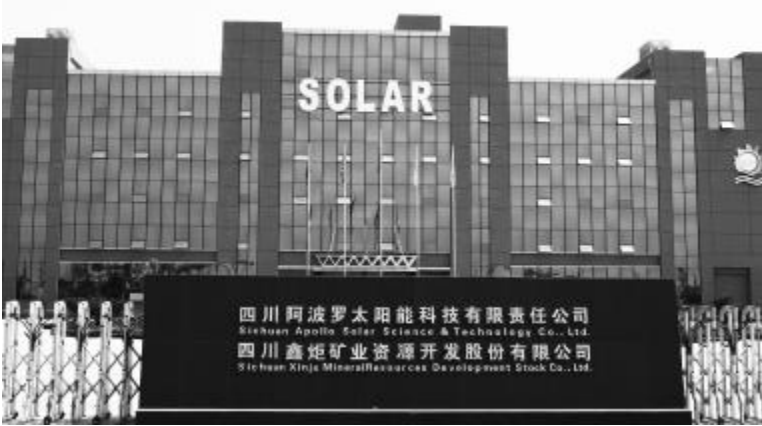
光伏产业项目——阿波罗太阳能
