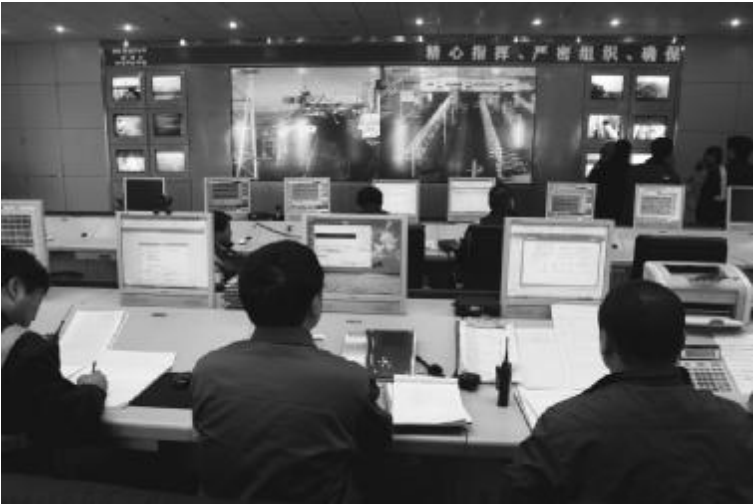
河北港口集团秦皇岛港煤五期中控室
