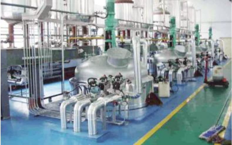
◀ 生产基地生产车间一角
