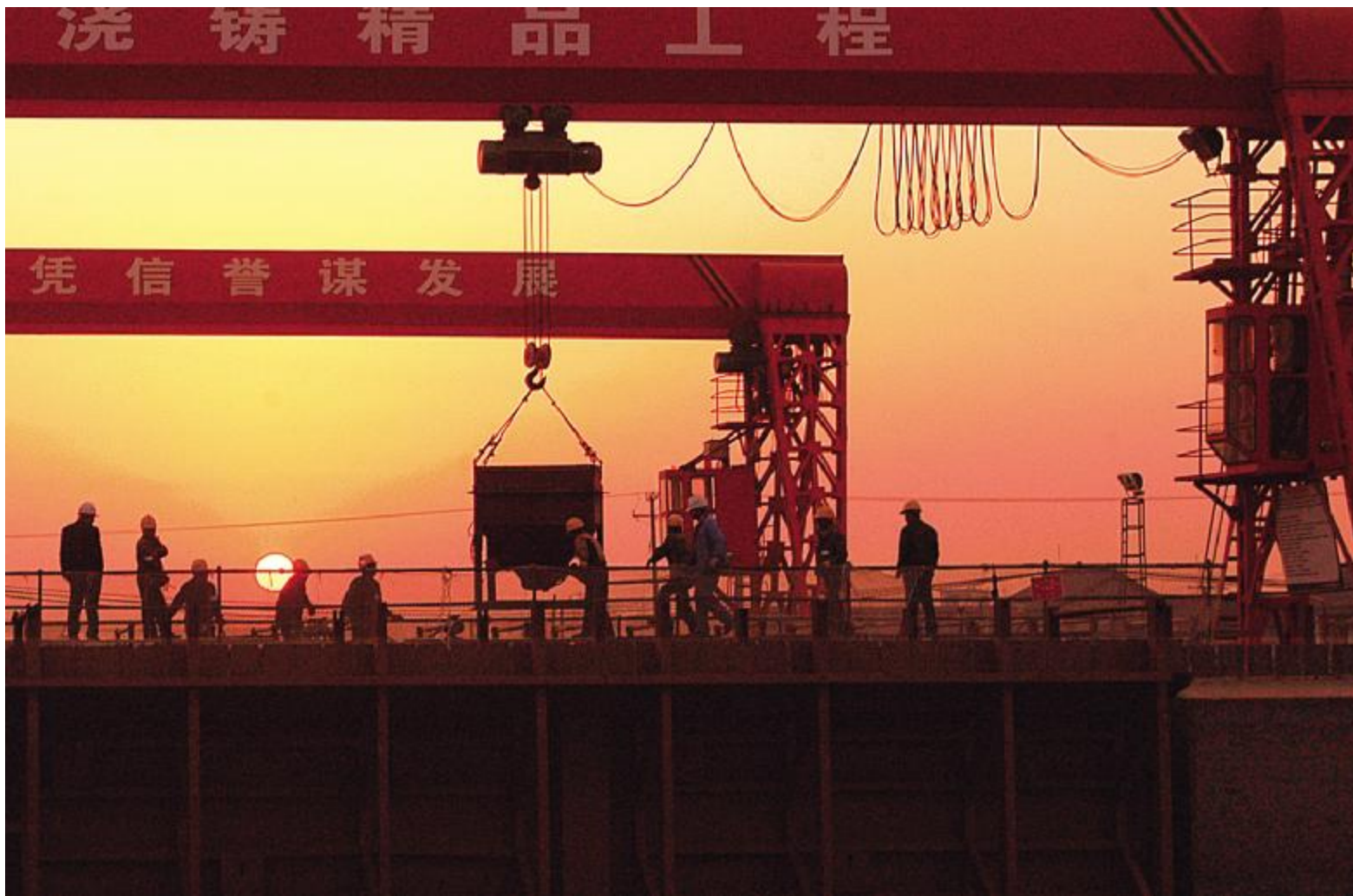
中国交通建设集团有限公司 夕阳下忙碌的施工现场
