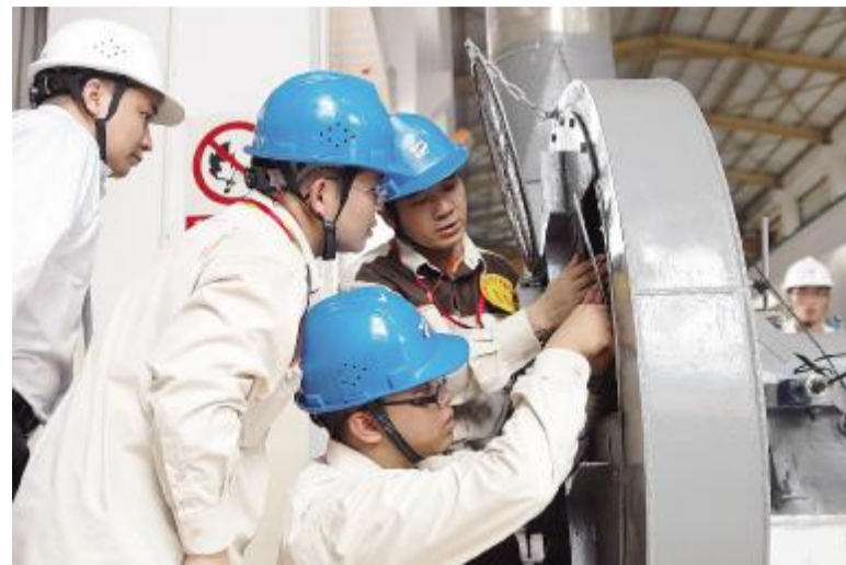
中国电力建设集团有限公司 工程技术人员精细检测设备
