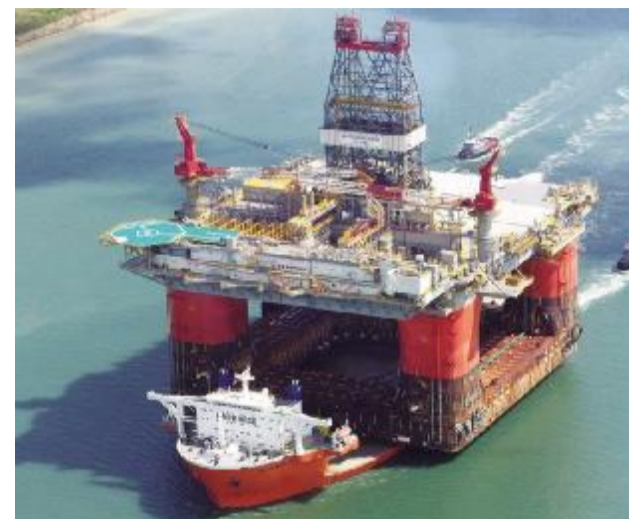
中海油 公司在发展传统能源的同时,不断加快清洁绿色低碳能源的开发和循环经济的发展,探索新产业,推动产业转移
