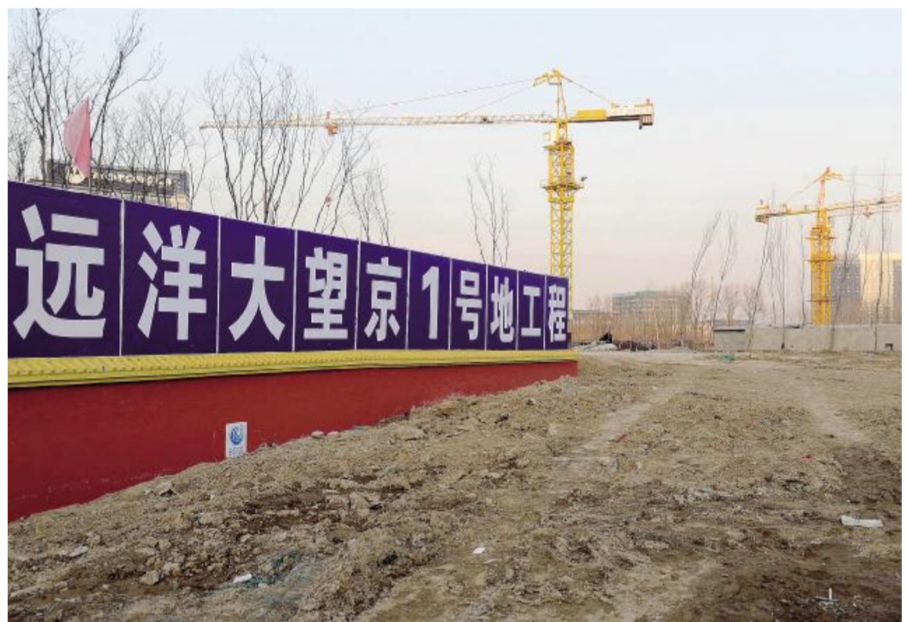
位于北京朝阳区的大望京1号地块项目, 只挖了两个大坑, 拿地快两年了, 还在浇灌地基
