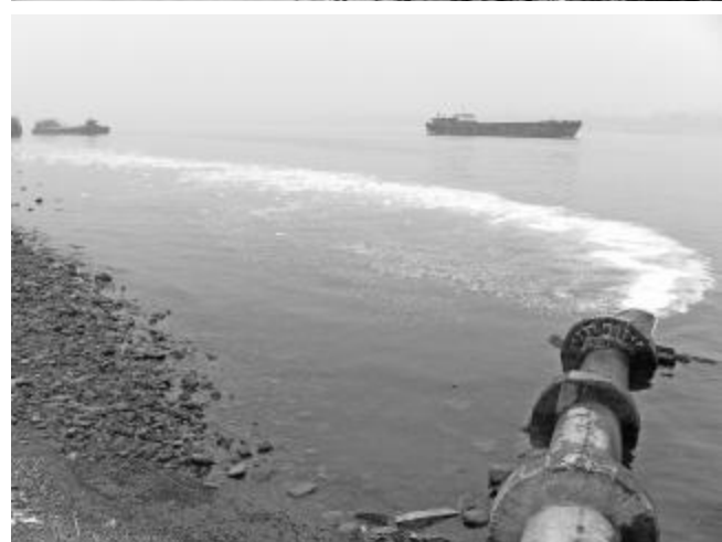
在长江中游湖北宜昌市猗亭区古老背轮渡口附近,某纺织印染厂的化工污水通过在江边建设的管道直接排入长江,在江面上泛起白色泡沫犹如“白龙游江”。CNS供图
