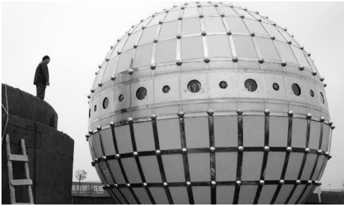
江西省南昌市“豫章明珠”景观灯在赣江畔南昌大桥南侧安装完毕。该景观灯是目前南昌市“最高的一座景观灯”,其高54米,共有1276个LED灯和18盏射灯,组成直径为8米的灯球。届时,它将隔江相望的南昌红谷滩夜景“相映成辉”,为南昌夜色再添一亮点。 CNS 供图
