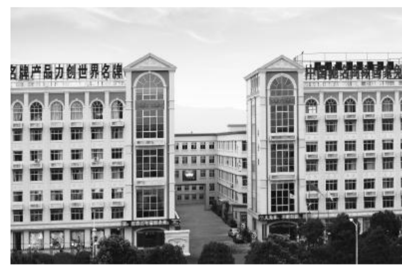
盛宇集团有限公司办公楼
