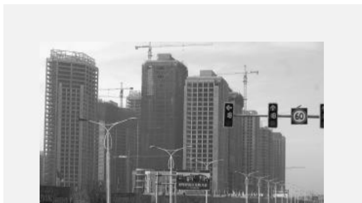
即将完工的项目
