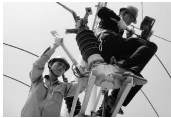
检修班技术人员正顶着烈日进行刀闸缺陷处理
