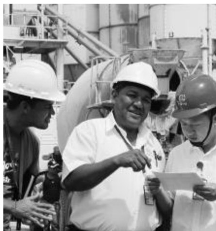
委籍环境工程师卡比列(左一)、比德里(中)与中方工程师在项目部混凝土拌和站共同商讨环保施工方案
