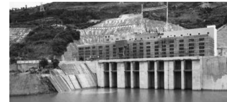
竣工后的发电厂房
