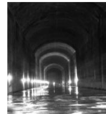
漂亮整洁的董管水电站2号导流洞
