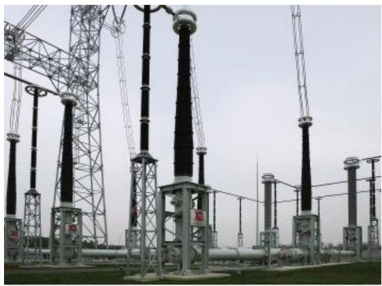
西电研制的1100kV VHGIS断路器在特高压示范工程荆门站运行
