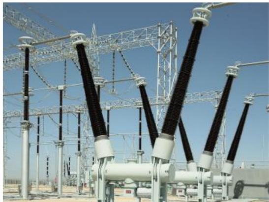
西电依靠自有技术研制成功的世界首台800kV双断口罐式断路器在国家首条750千伏输电工程运行
