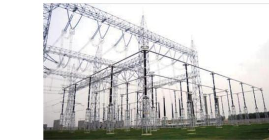
西电自主研发的1100kV棒形支柱绝缘子在荆门变电站运行
