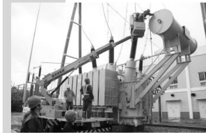
迎峰度夏前220千伏变电部主变大修检修
