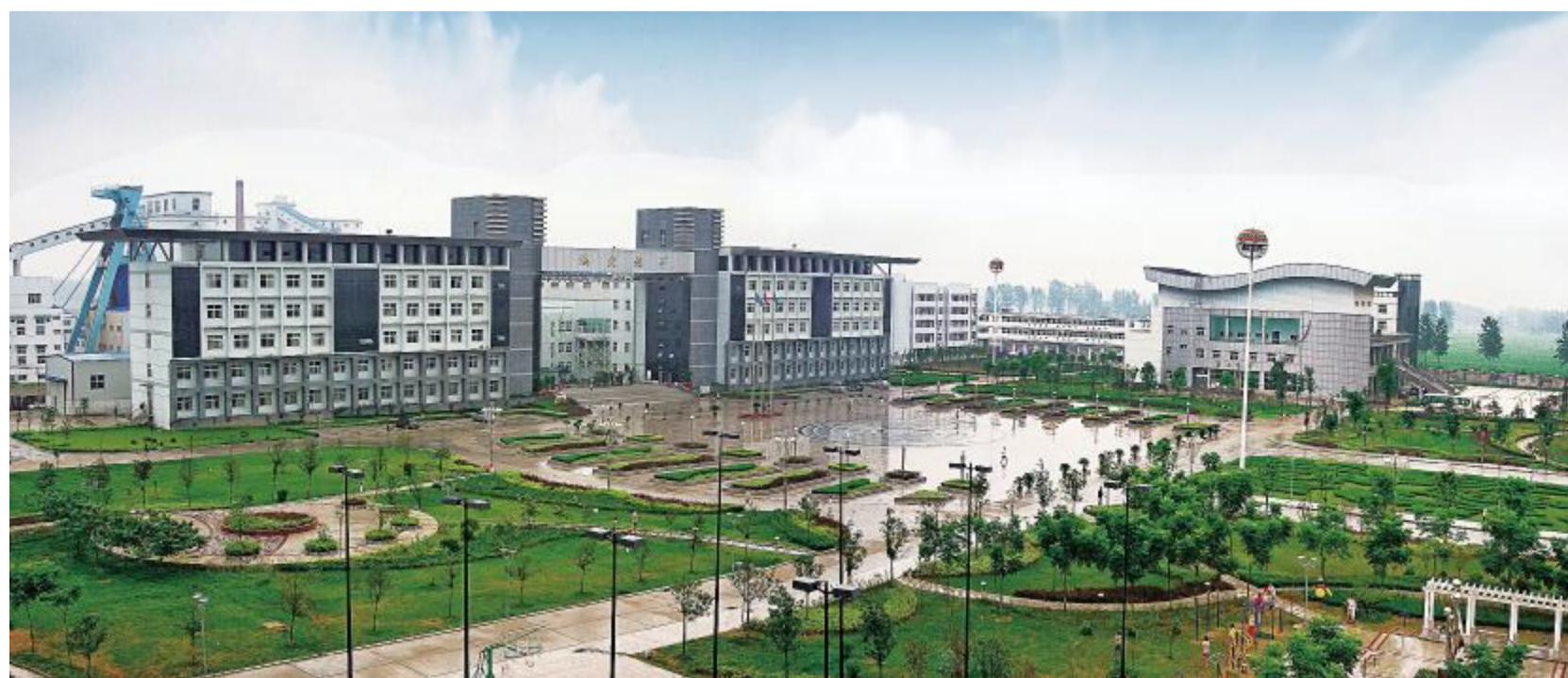
涡北煤矿全貌
