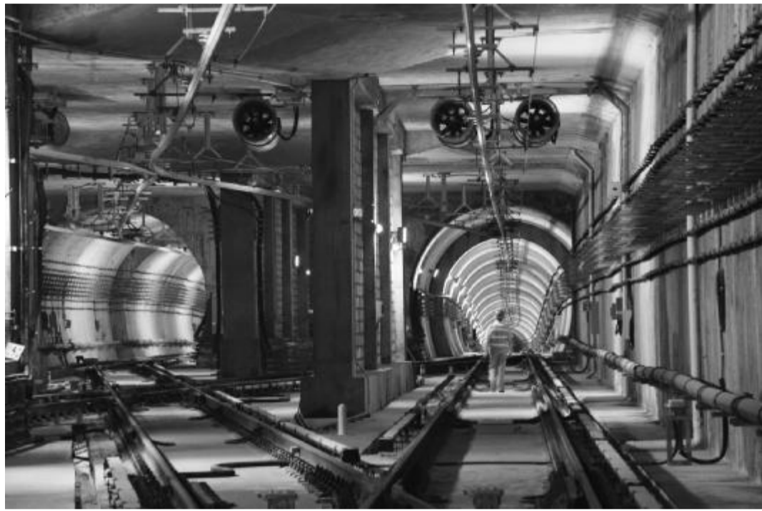
参建深圳地铁五号线 黄朝华/摄
