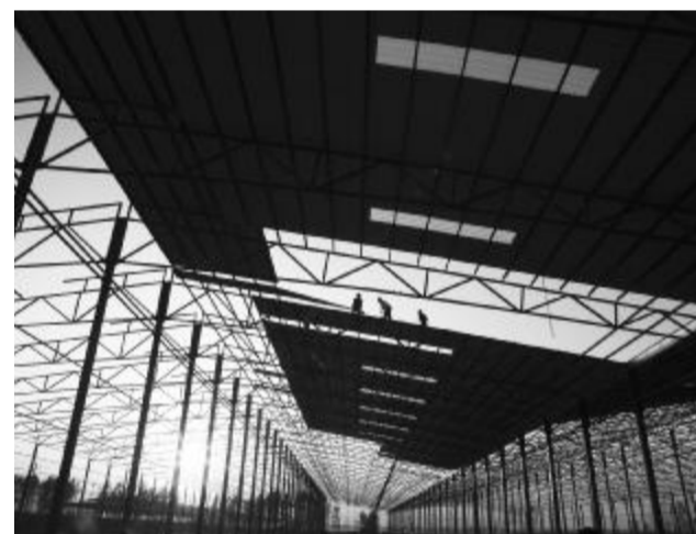
正在建设中的“中原瓷都”
