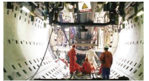
集团施工的天津地铁三号线工程获“海河杯”
