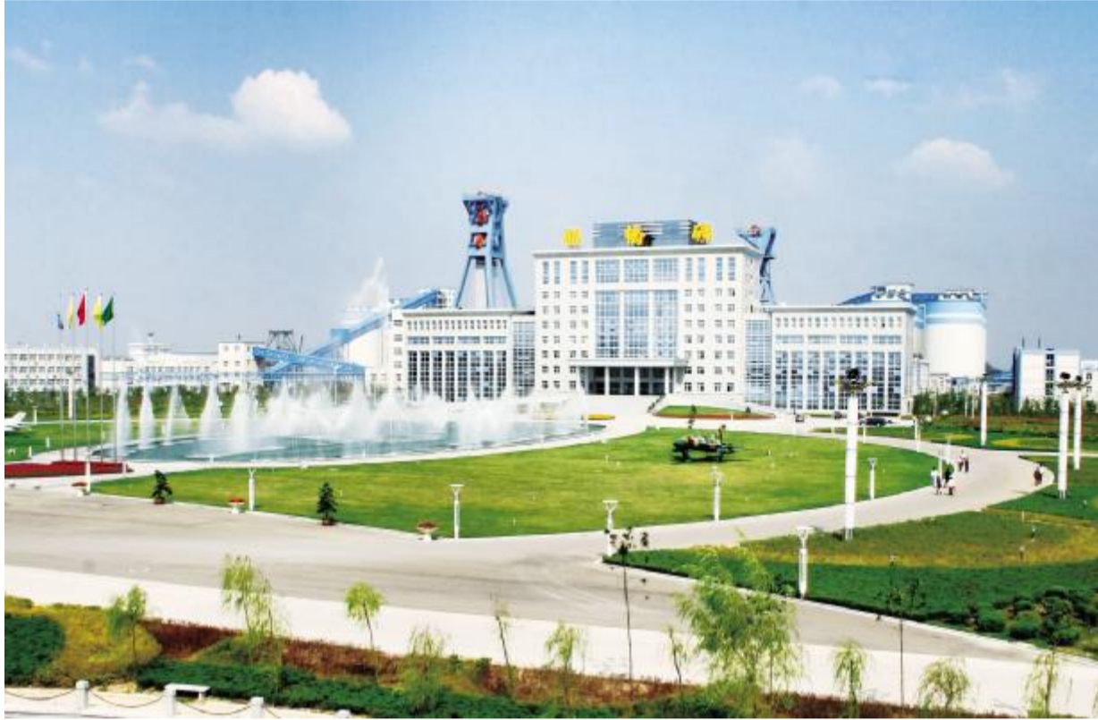
集团参与建设的年产1000万吨的安徽顾桥煤矿获“鲁班奖”
