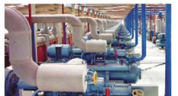
安徽口孜东煤矿主副井冻结深度为737米,是目前亚洲采用冻结法施工的最深井筒,总装机容量为世界最大
