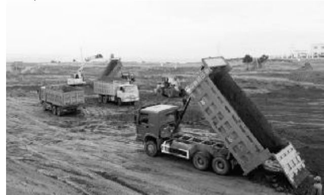
建设中的盐源县工业集中区
