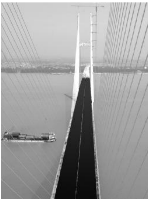
由天津城建滨海路桥有限公司使用环氧沥青摊铺工艺施工的第三座长江大桥——荆岳长江大桥于2010年12月9日顺利通车。
