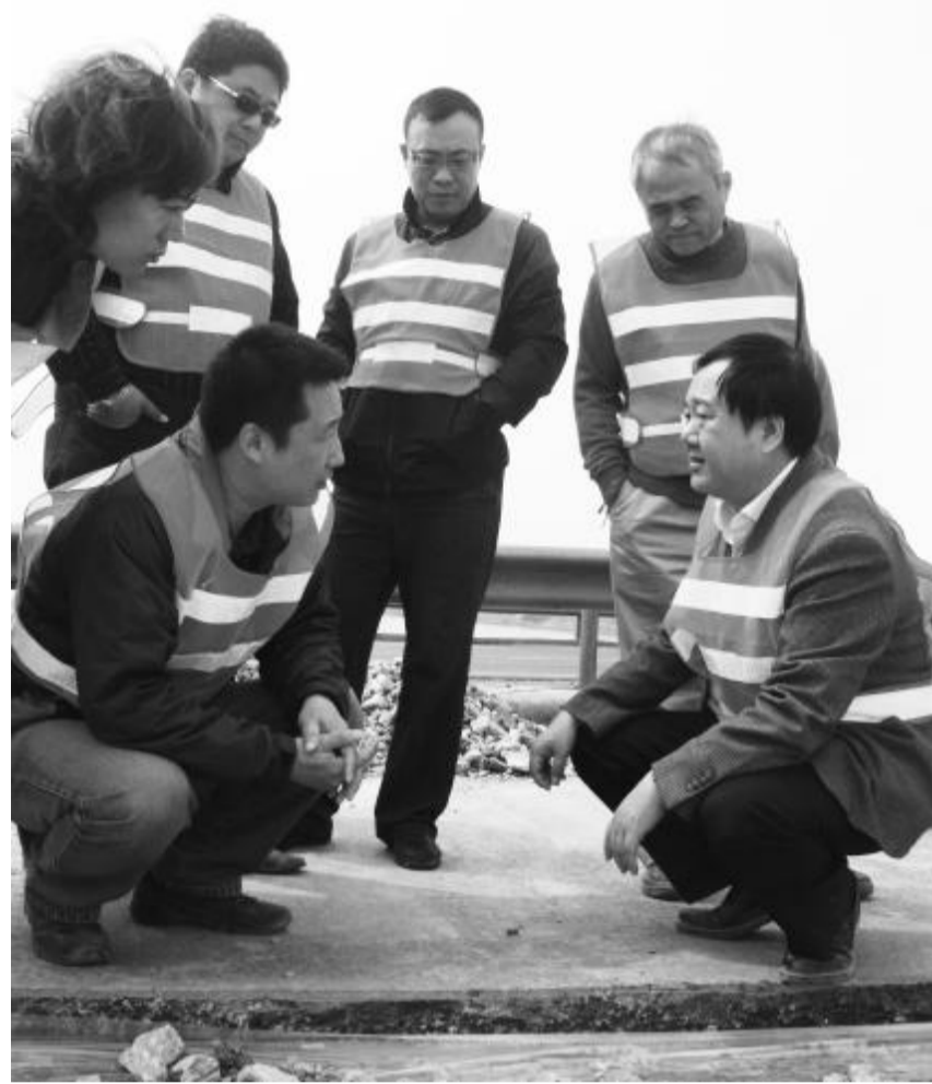
公司主要领导在施工现场检查工程质量
