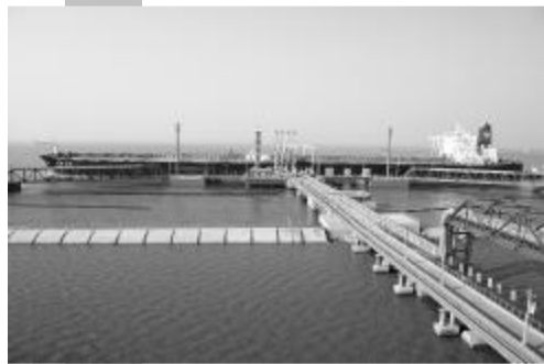
天津港30万吨级原油码头
