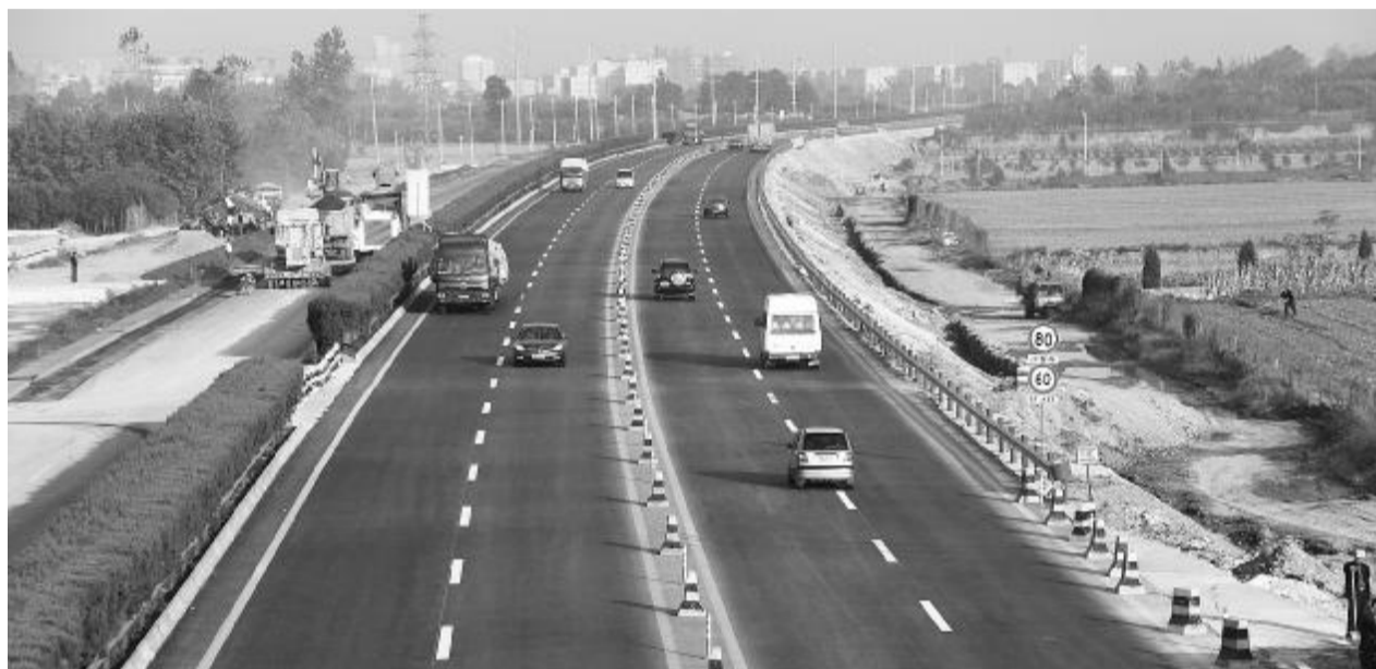
陕西改扩建工程——西潼高速公路一景
