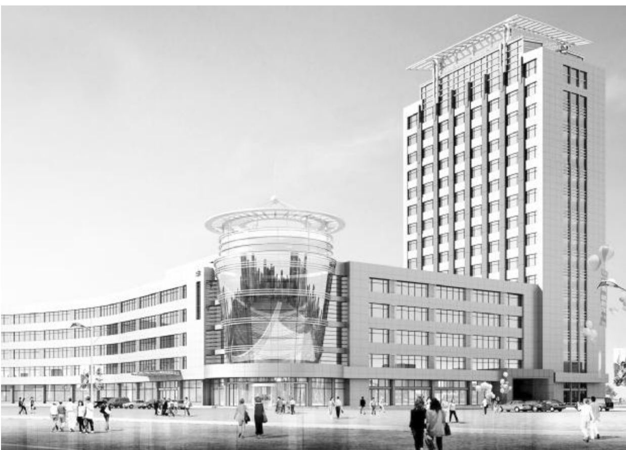
济南军区八一柔道队沿街综合楼
