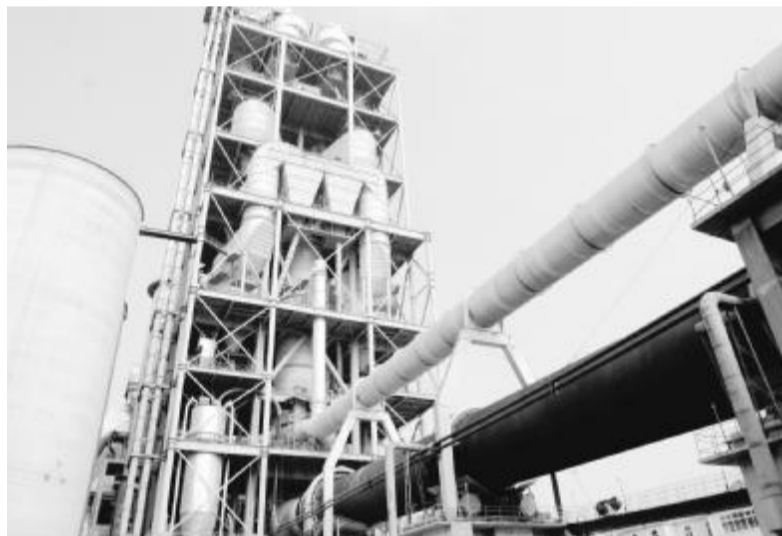
徐州中联日产万吨新型干法水泥生产线
