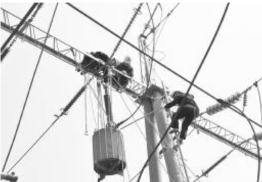
220KV 卵石变阻器带电加固改造 潘明/摄
