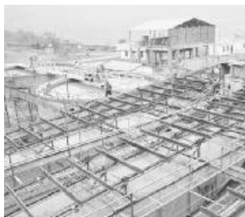
溪洛渡水电站大坝人工骨料加工系统废水处理运行图
